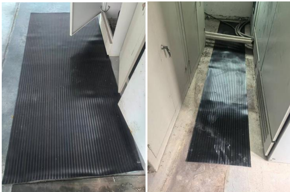
附图 6.1-5 已在配电装置柜前配备绝缘垫
