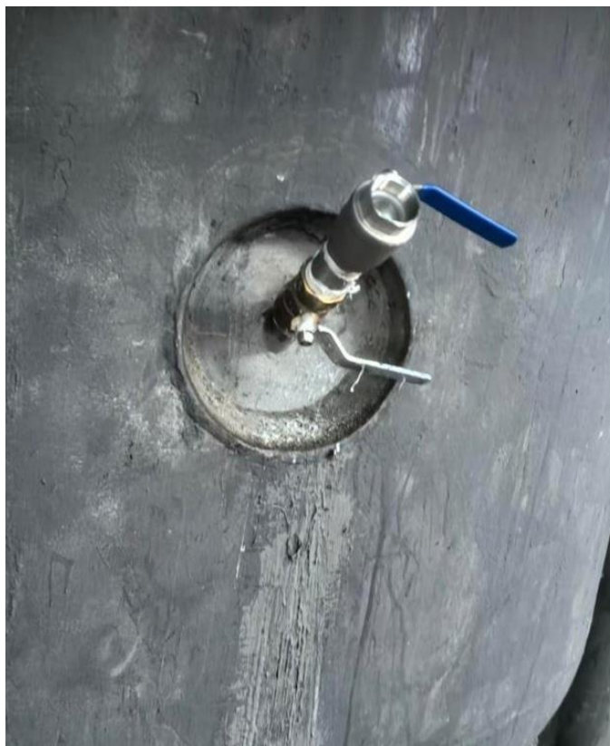
附图 6.3-11 采样口已设置为双阀
