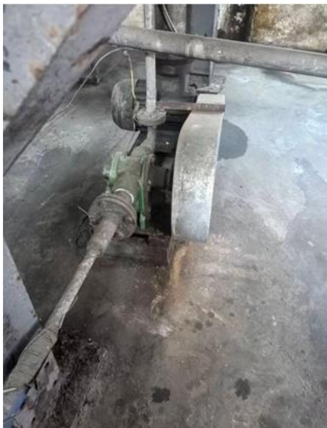
附图 6.3-12 已将厂房内机泵的防护罩安装到位
