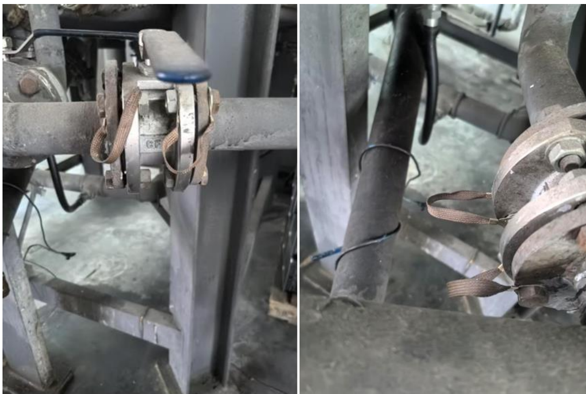
附图 6.1-6 跨接线断开的法兰盘已重新设置跨接线
