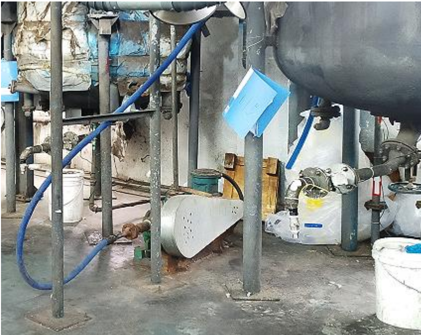
附图 6.1-2 输送泵的防护罩已增设
