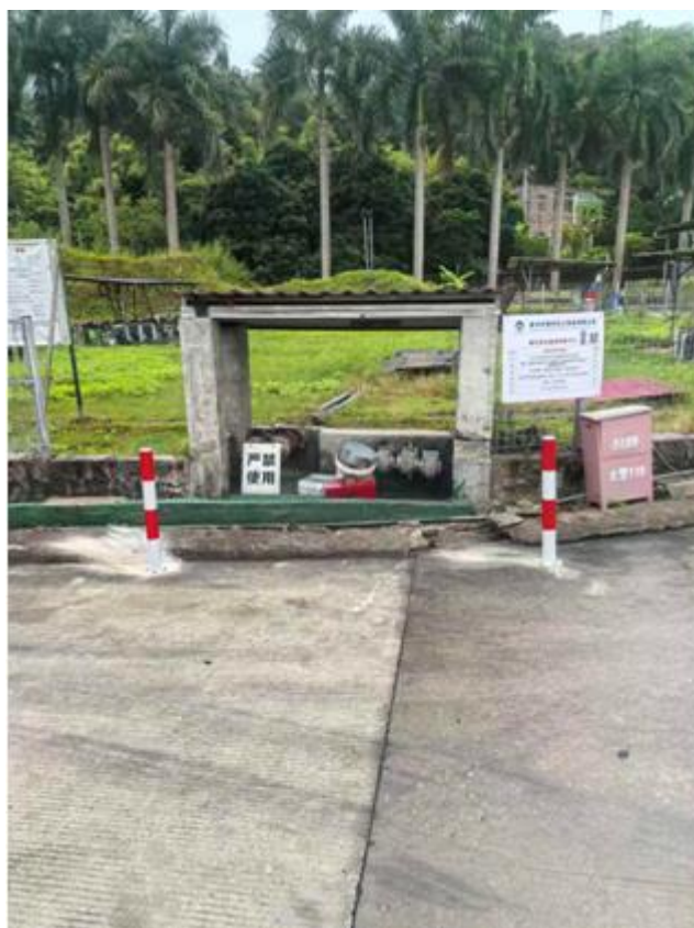
附图 6.3-13 已修复罐区卸车区损坏的防撞柱
