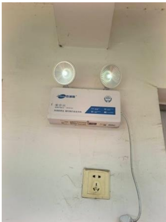
附图 6.3-1 原倒班楼（现功能修改为综合楼，二层为食堂，其余空置）内楼道应急照明灯已修复，一楼楼梯间配电箱前的杂物已清理
