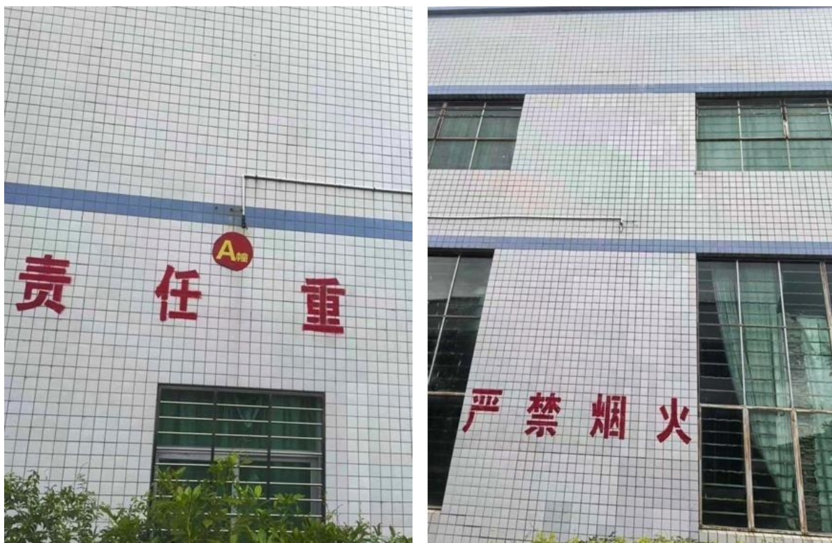
附图 6.3-3 已拆除甲类仓库外非防爆的照明灯具
