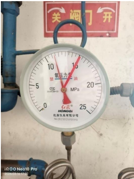
附图 6.1-3 已在压力表表盘上划出指示工作压力的红线
