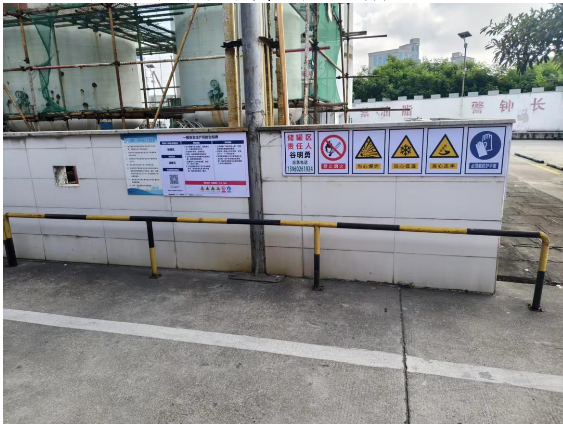
附图 6.3-4 室外贮罐区已设置围墙和围栏，并设置安全警示标识
