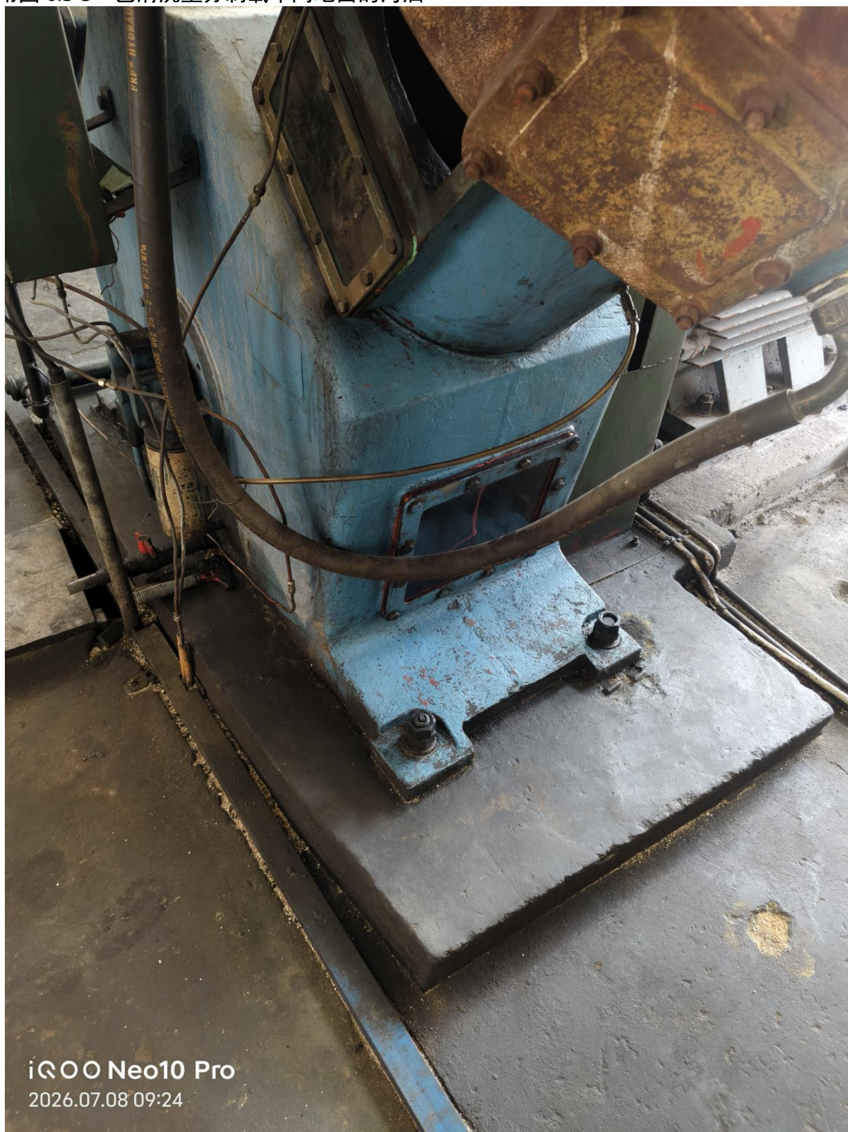
附图 6.3-3 已清洗空分制氧车间地面的油污
