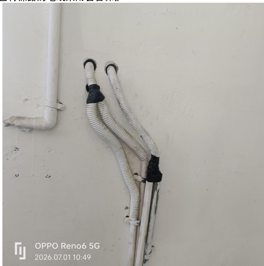
附图 6.3-1 已将裸露的电线采用套管保护
