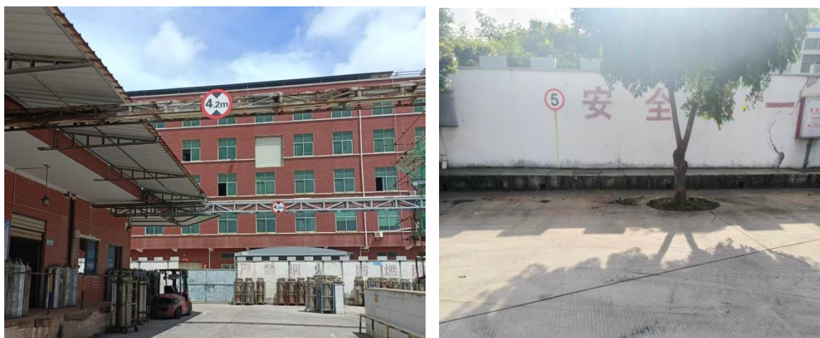
附图 6.3-10 跨路管架上现仅设置限高标识，另在厂区道路转弯处设置限速标识
