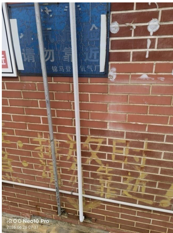
附图 6.3-8 已按规范对液氧进行排放，排放管穿过车间地面后沿车间外墙敷设至高空排放，未排放至地沟
