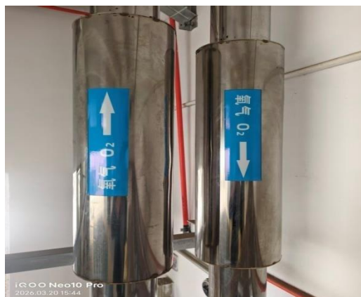
附图 6.1-2 已完善管道上介质标识、流向标识的设置
